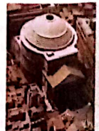
الخرسانة الخضراء البوزلانية أطالت العمر الافتراضي للمباني الرومانية أكثر من ٢٠٠٠ سنة
