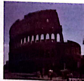
الخرسانة الخضراء البوزلانية أطالت العمر الافتراضي للمباني الرومانية أكثر من ٢٠٠٠ سنة
