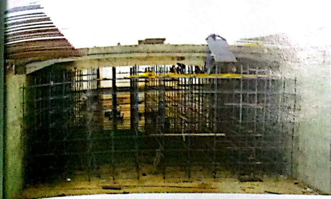
أعمال طوبار عقدة النفق
