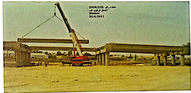
أعمال تركيب الجوائز مسبقة الصب لاحقة الإجهاد
