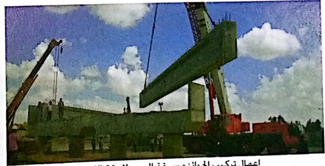
أعمال تركيب الجوائز مسبقة الصب لاحقة الإجهاد
