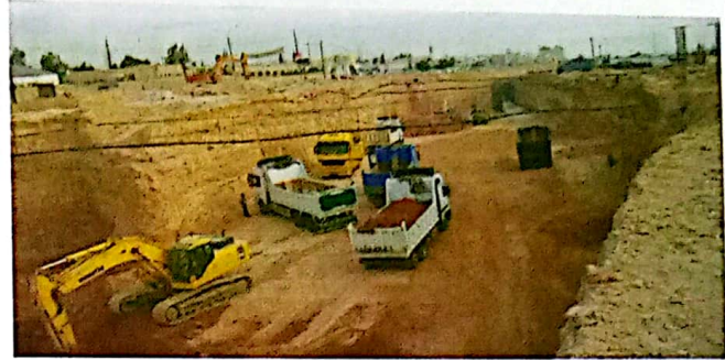
أعمال الحفر للنفق وقواعد الجسر
