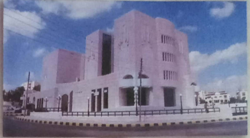
مبنى اتصالات تلاح العلي / عمان ١٩٩٦
